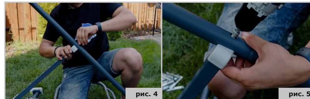
В ножках используются ВТУЛКИ-12 мм, в площадке – ВТУЛКИ-10 мм.
